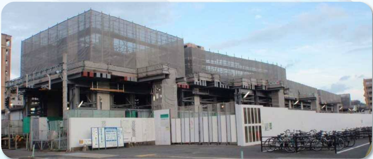
現在高架工事中の白木原駅
